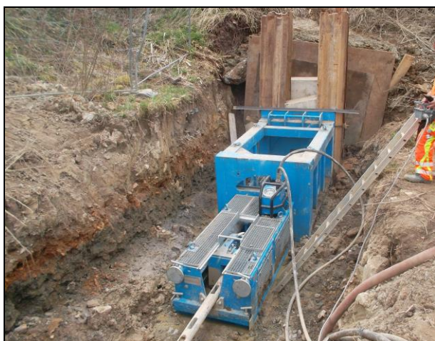
Abbildung 8: Zugeinrichtung für das TIP-Verfahren
