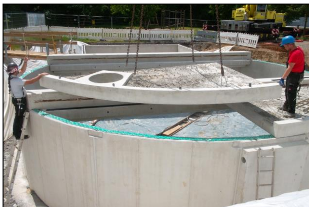
Abbildung 4: RÜB Denklingen als Betonbauwerk
