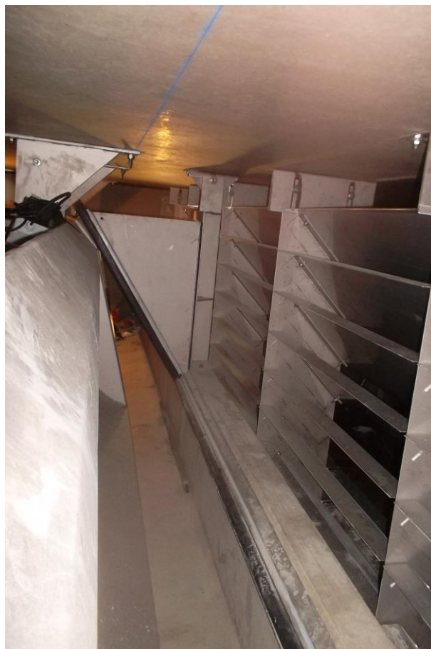
Abbildung 6: Kulissentauchwand am Überlauf
