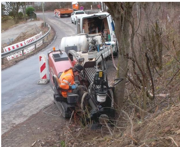
Abbildung 11: Herstellung von Hausanschlussleitungen im Spülbohrverfahren
