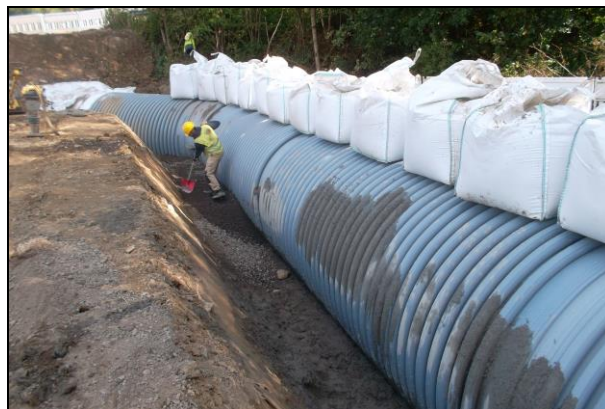
Abbildung 9: Auftriebssicherung aus Bigpacks während des Einbaus von Flüssigboden
