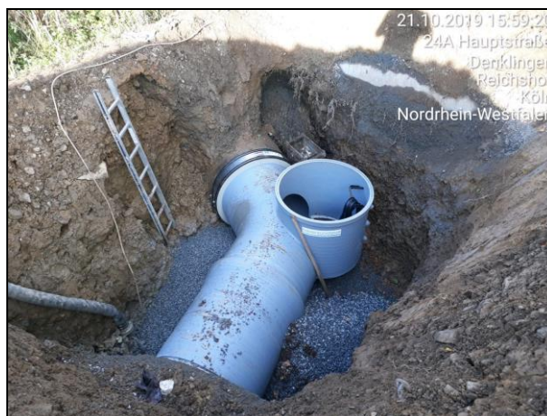
Abbildung 5: Sammler und Verbindungsbauteile aus Polypropylen
